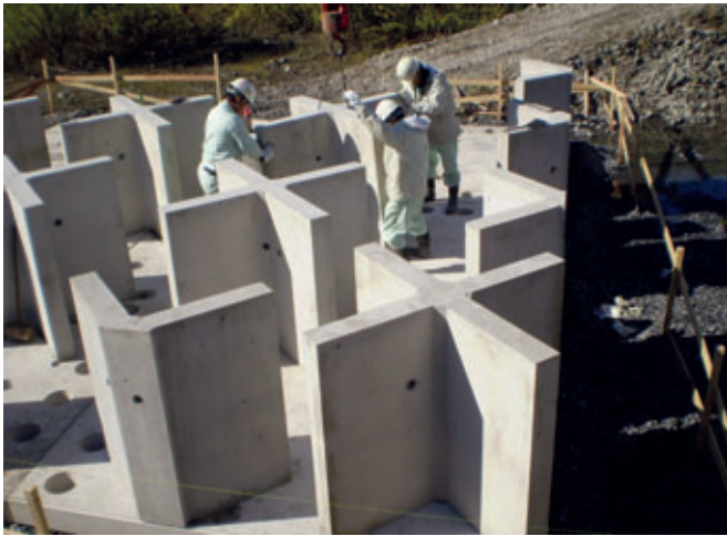
Figures 5 et 6 : montage de la citerne à eaux pluviales en forme de X
